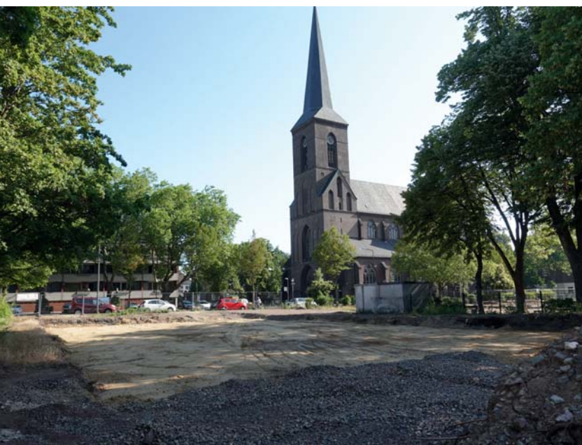
Das Grundstück gegenüber der Kirche St. Marien ist vorbereitet für den Neubau der Kindertagesstätte.
